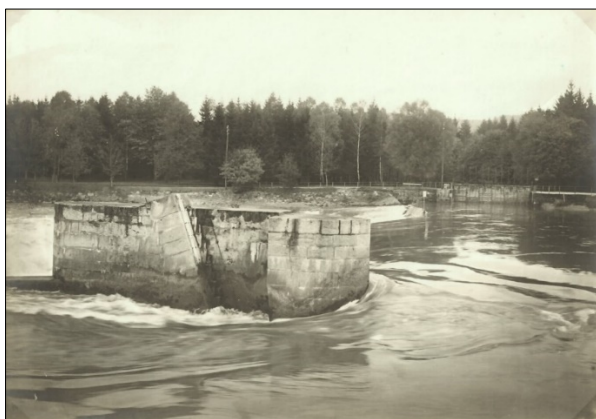
Walzenwehr beim Kanaleinlauf, erbaut 1906. Foto um 1915.
